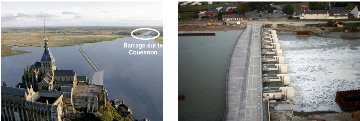
FIGURE 4.1 – Barrage du Couesnon.
